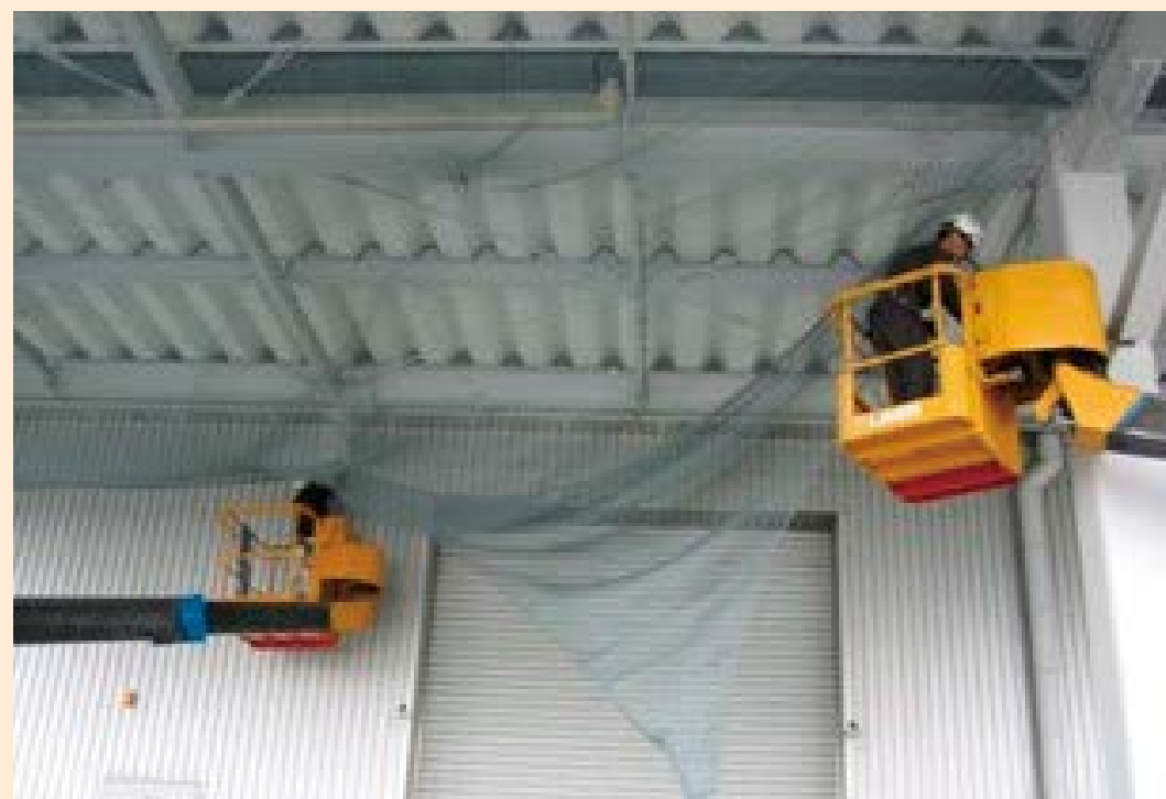
防ハトネット工事 例1
