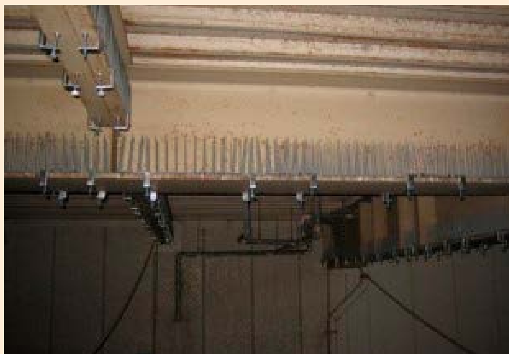
防ハトプロテクター工事
