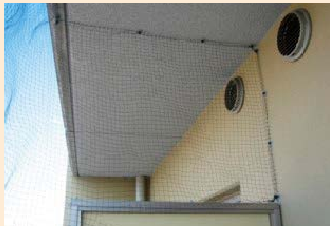
防ハトネット工事 例2
