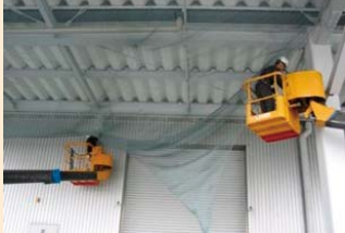
防ハトネット工事 例1
