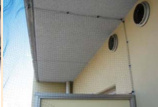
防ハトネット工事 例2
