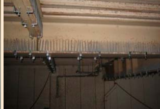
防ハトプロテクター工事
